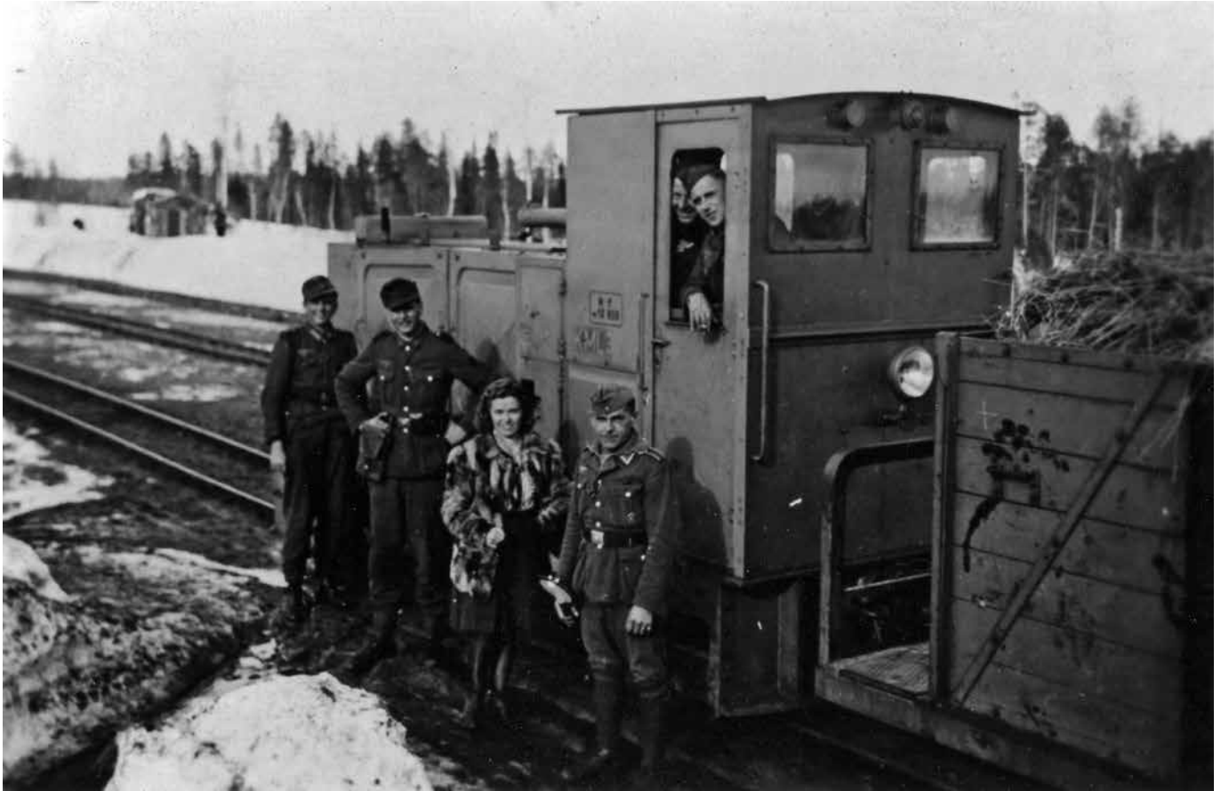
Saksalaisilla oli Hyrynsalmen – Kuusamon radalla 35 kappaletta kuvan esittämiä 130 hevosvoiman dieselvetureita. Maksiminopeus oli 18 km/t. Lisäksi oli kymmenkunta höyryveturia. Kuva on otettu jollakin radan varren asemalla. Kuva: Torstai-lehti, Alajärvi/Marja Heikkisen albumi
